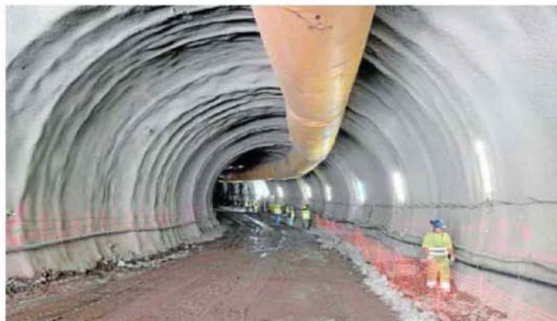
Interior del túnel principal de la central hidroeléctrica que se construye desde Las Filipinas. REE
