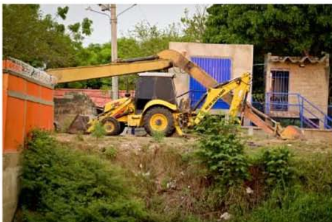
Se realiza mantenimiento y limpieza en las compuertas para la captación del líquido.
