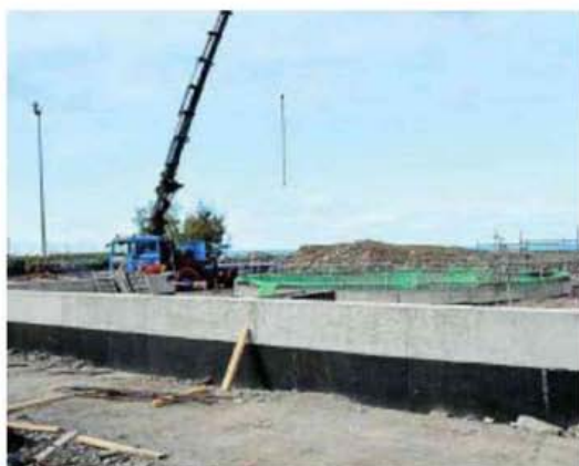
Trabajos de construcción de la cántara de captación, en la costa. A. SUÁREZ
