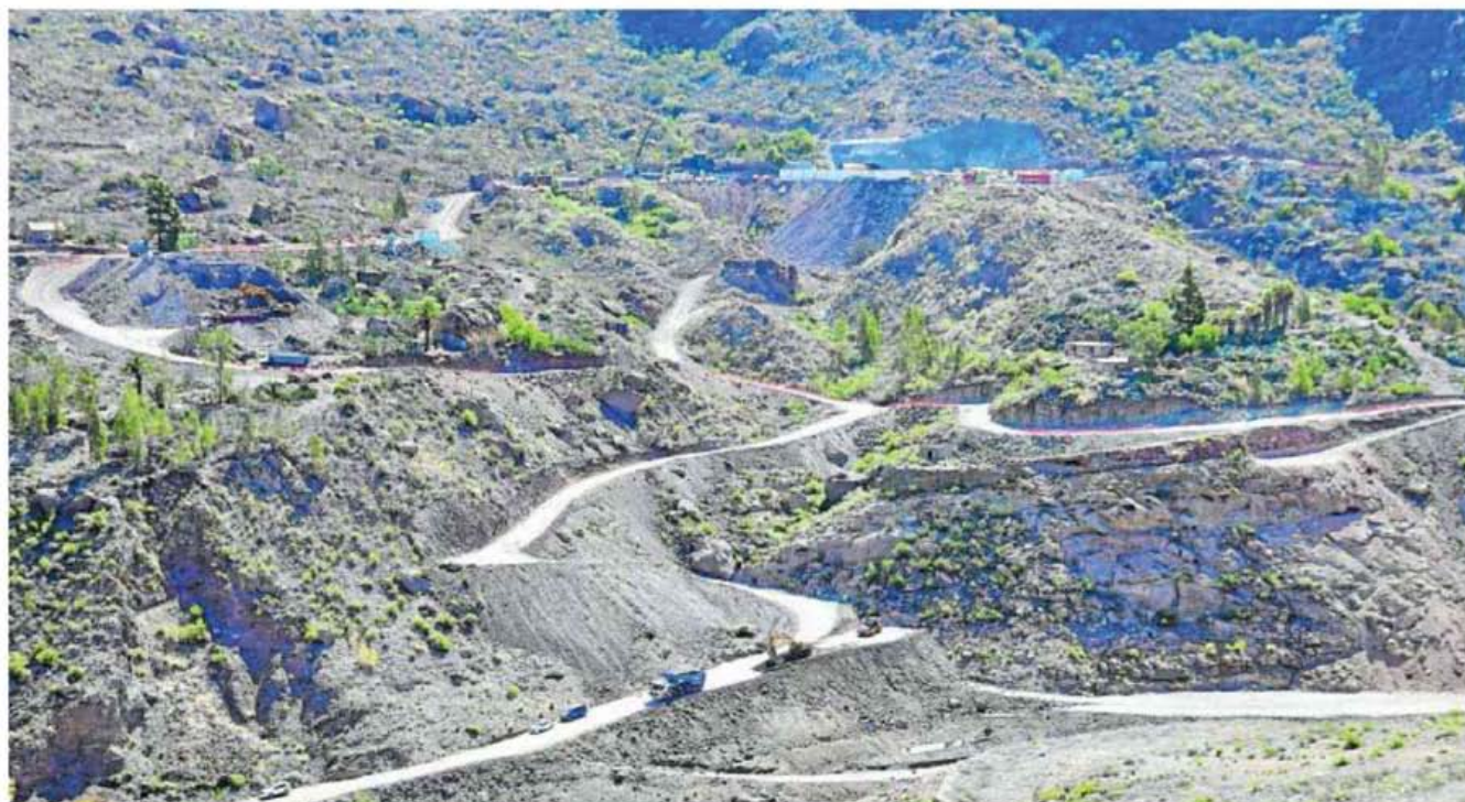
El trasiego de maquinaria en la presa de Soria es notable. En la imagen, arriba, se observa la boca del túnel secundario de la central, por la que el agua entrará al embalse. ARCADIO SUÁREZ
