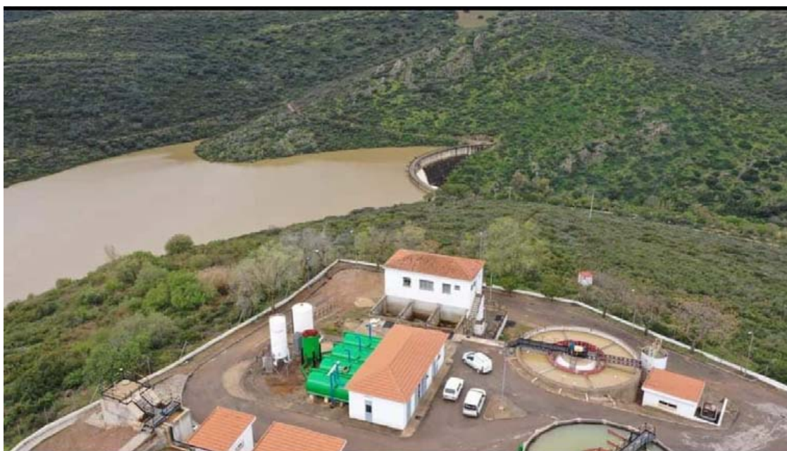
Desde el embalse de Fresneda hasta la E.T.A.P. el agua es impulsada mediante dos bombas/ Ayuntamiento
