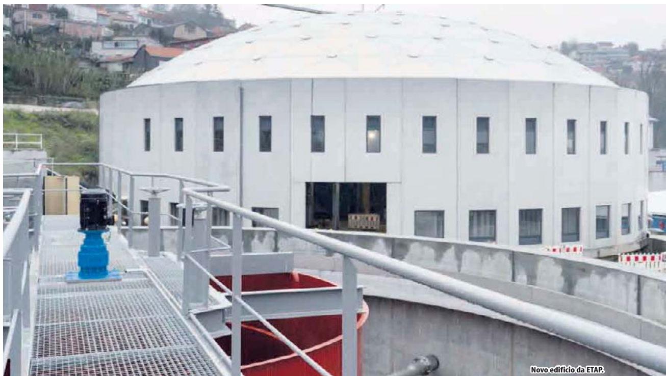
Novo edificio da ETAP.
