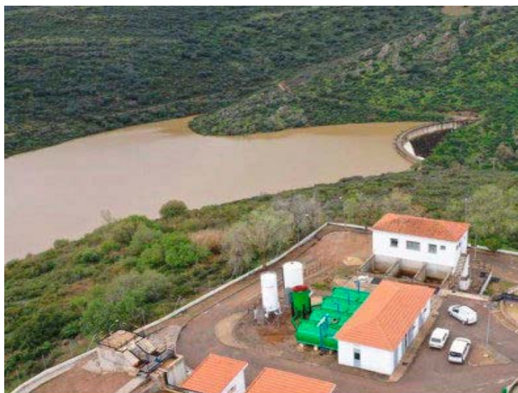
La Estación de Tratamiento de Agua (ETAP). / LT
