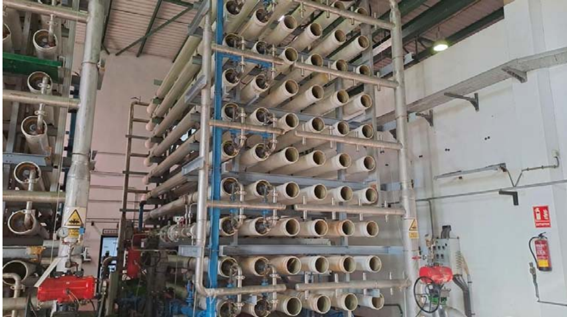
El bastidor que se está renovando en la planta de Racons de Dénia / Levante-EMV
